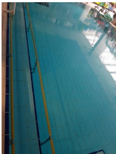
תמונה 3: מעקה בצבע צהוב שהוא צבע ניגודי לצבע הכחול (נועד במקרה זה לקביעת גבול הליכה)
