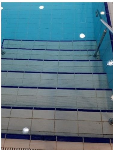
תמונה 2: גרם מדרגות הכניסה לבריכה, בקצה כל מדרגה מודבק פס בצבע בולט עם מרקם
